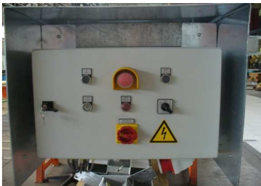
Figura 04: Consola de control en el cuadro de maniobra
