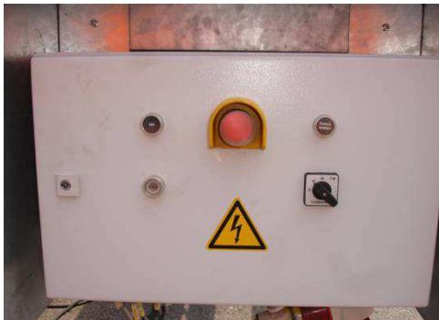
Bild 02 – Bedienpult mit Not-Aus-Taster
