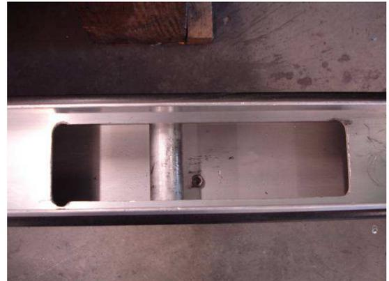
Bild 03 (Bolzen der Dammtafel)
